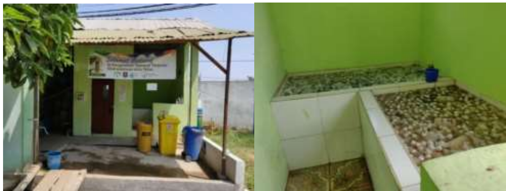
Gambar 3-13 Fasilitas Disinfeksi Plabot Bekas di RSUD Kardinah Tegal
