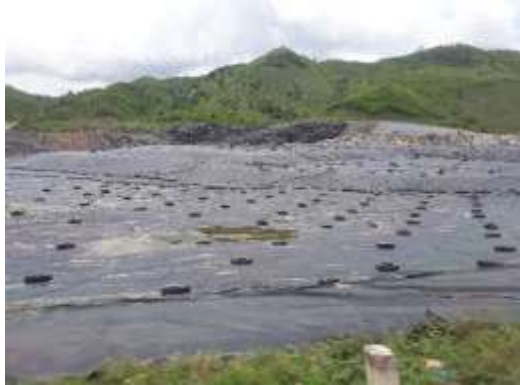
Landfill yang sudah ditutup
